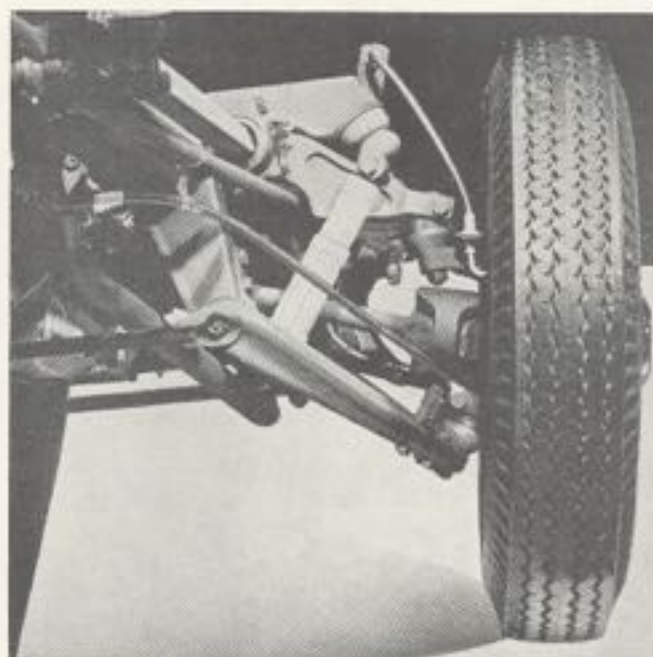
Freischwingende Einzelrad- Aufhängung
